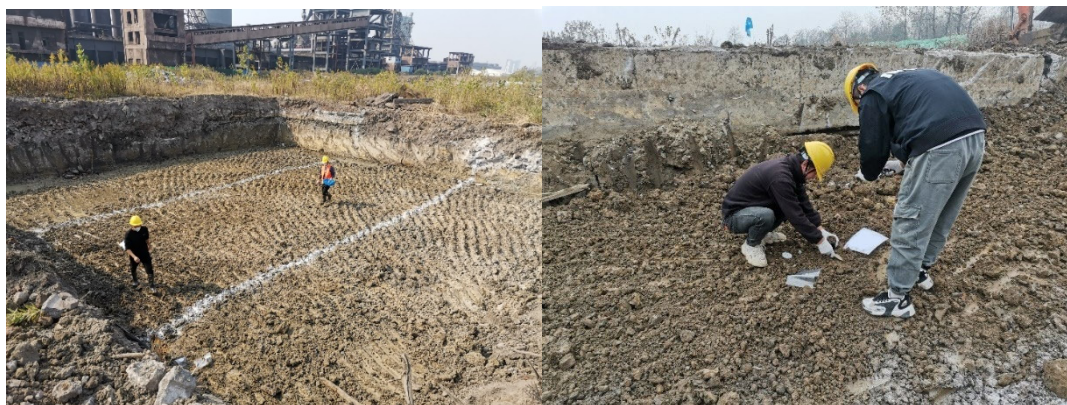
图 10.2-3 基坑清挖自验收采样示意图
