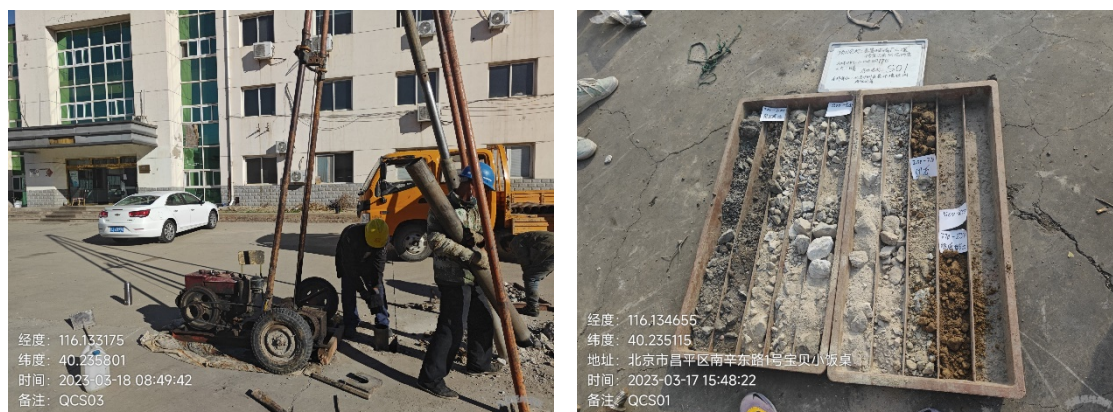
图 1.4-3 现场钻探施工和钻孔岩心照片
